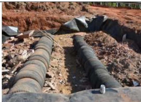
Figura 2b – Instalação dos pneus formando câmaras de recebimento de efluentes.
