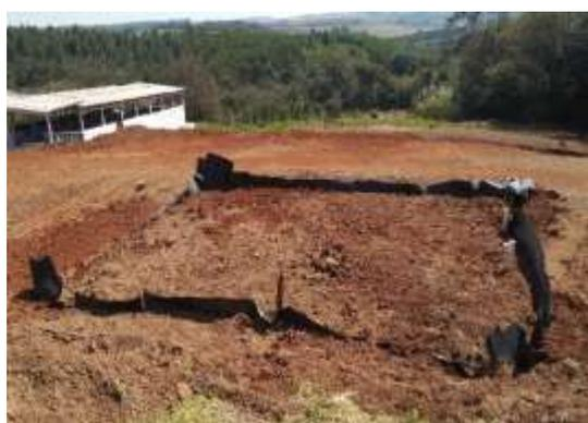
Figura 2e – Bacia de evapotranspiração concluída e camada de solo sobre a areia.
