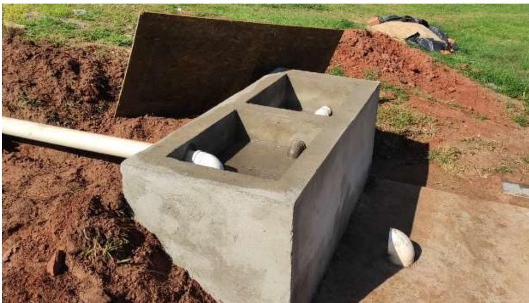
**Figura 3:** Caixa de gordura em alvenaria.
