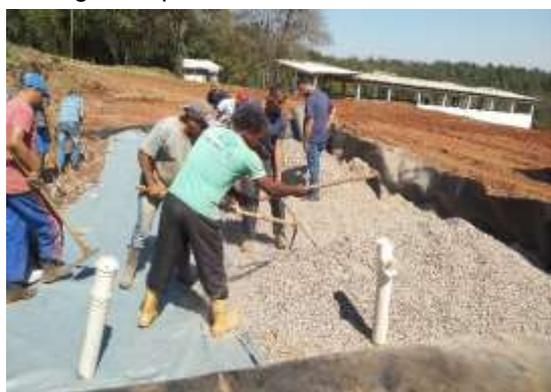
Figura 2c – Distribuição da brita sobre a manta geotêxtil. Detalhe para as tubulações.
