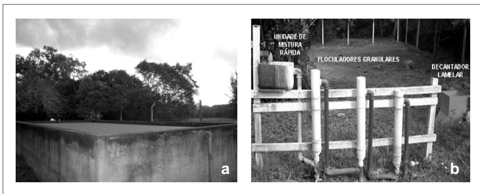
Figura 7.8 Sistema de tratamento UFES (a) Lagoa (b) Tratamento Físico químico
