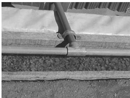
Figura 7.11 Caixa de brita para a distribuição do esgoto
