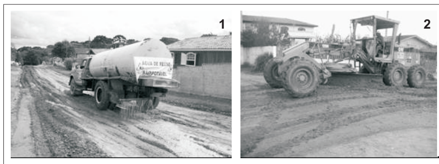
Figura 4.12 Ensaio de reúso da água em Campo Largo - PR (maio 2006). (1) Aplicação em compactação de estrada; (2) Atividades complementares da compactação.
