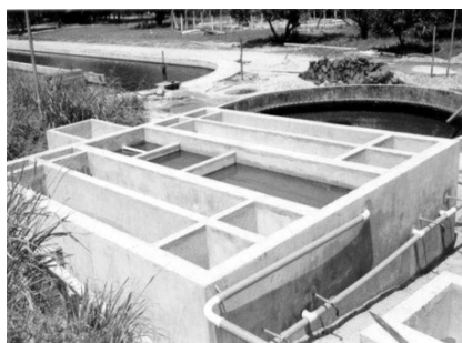
Figura 7.4 Filtro anaeróbio (UFRN)
