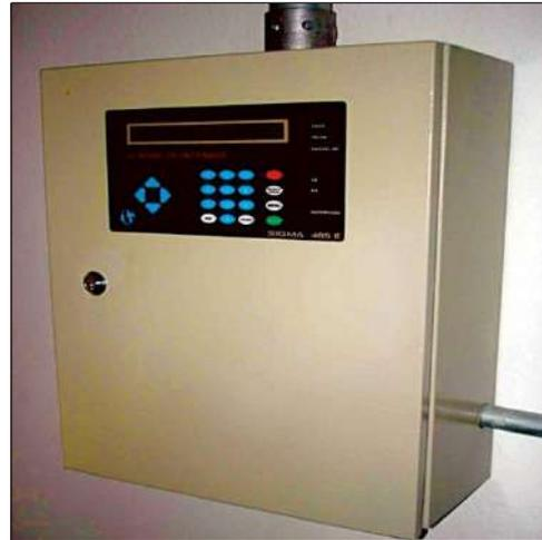
Figura 50: Central de alarme de incêndio
