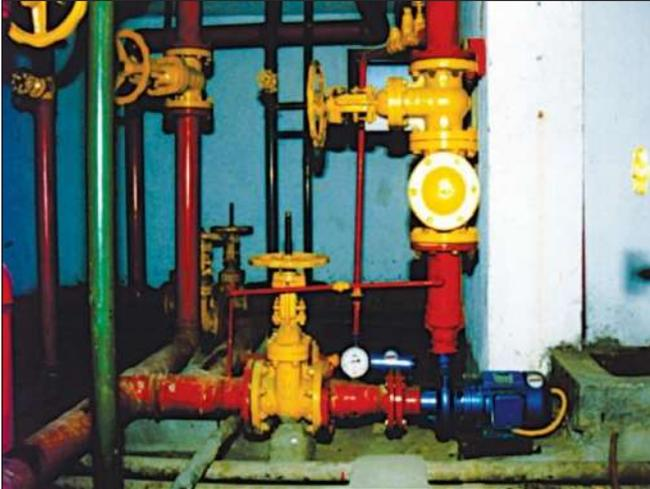
Figura 56: Bomba de incêndio e acessórios hidráulicos
