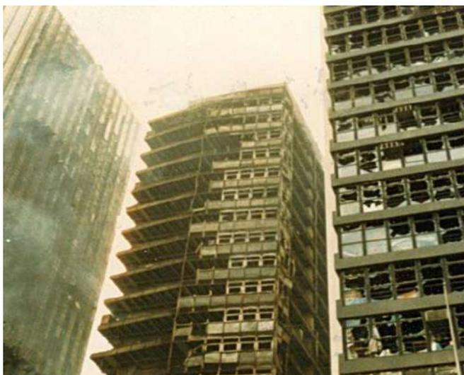
Figura 8: Propagação entre blocos
