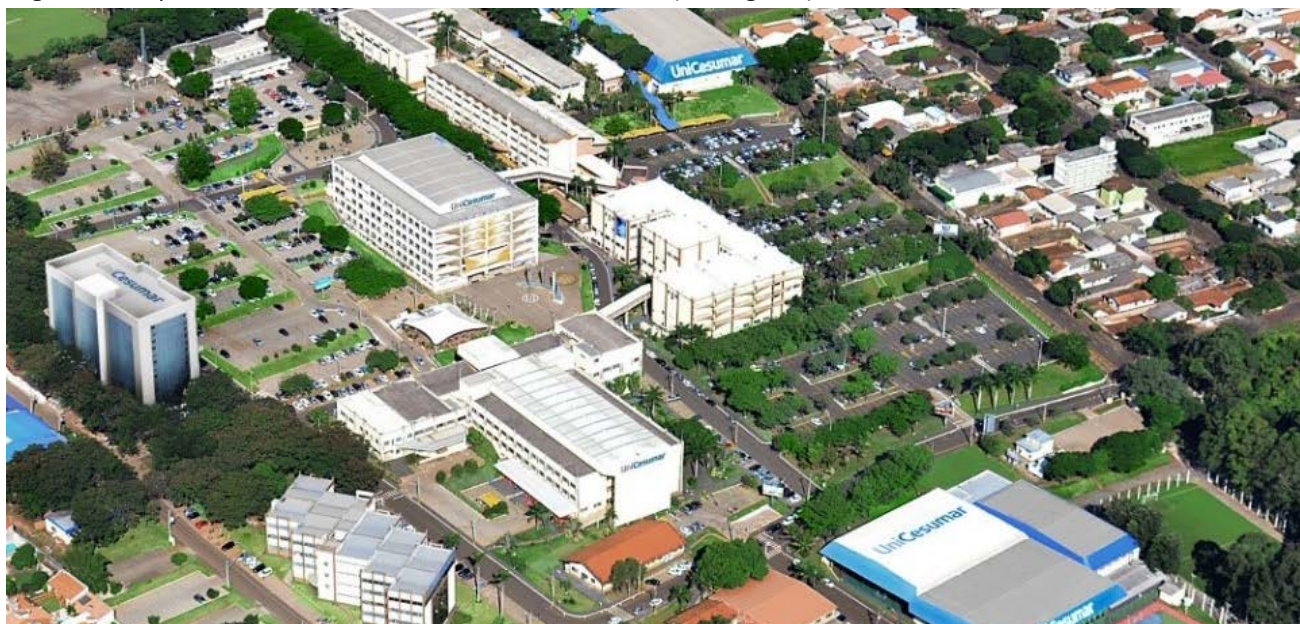
Figura 1. Campus Sede, Universidade Cesumar - UniCesumar (Maringá-PR).
