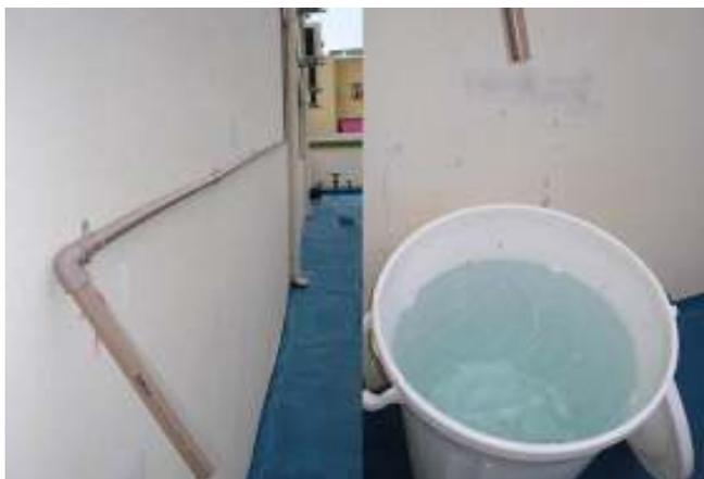
**Figura 4** - Conexão única de coleta de água dos drenos e recipiente de armazenamento.
