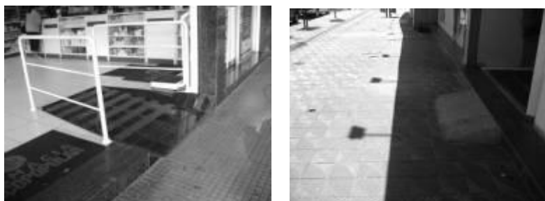
Figura 4 - Exemplos de acesso adequado e inadequado - Fonte: Arquivo pessoal
