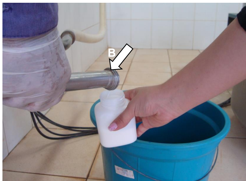
Figura 2: (B) Ducto que conduz o leite do sistema de ordenha mecânica ao tanque de armazenamento.
