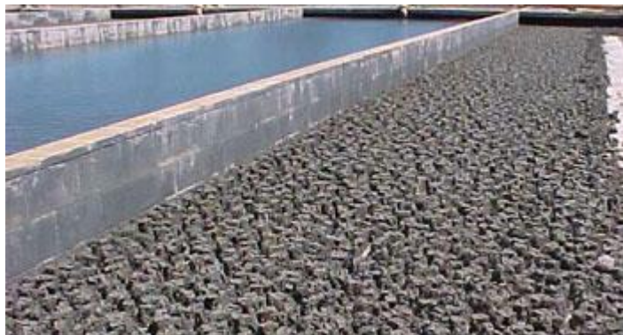
Figura 1: Lodo têxtil em poço de decantação.
