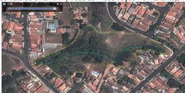
Figura 1: Vista de cima da área degradada.
