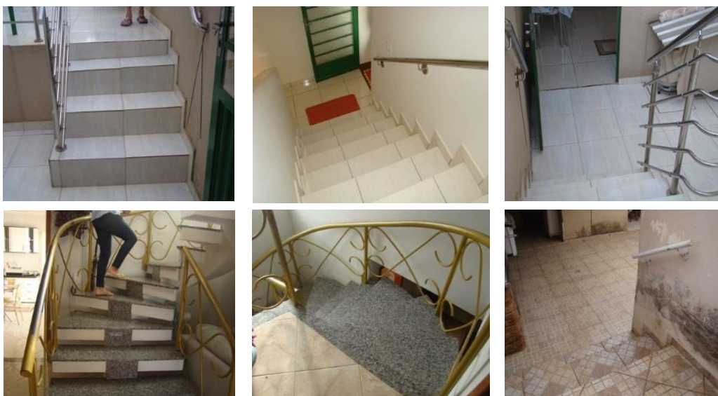
Figura 5: Escadas nas residências: (linha acima). Escadas na residência da An. (Linha abaixo): Escadas sem sinalização de níveis de degrau na residência de C. e (dir.) Escada motivo da queda em D. Fonte: Acervo Pessoal
