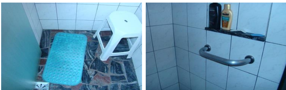
Figura 9: Banheiro de En. com tapete antiderrapante, banco e barra de apoio. Fonte: Acervo Pessoal
