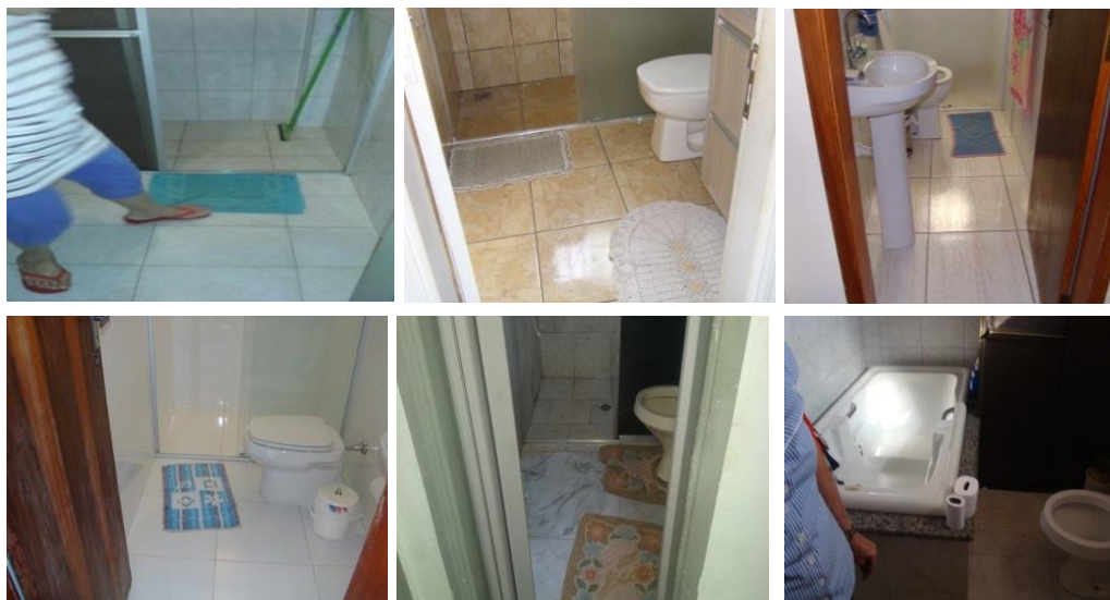
Figura 11 Banheiros sem nenhum dispositivo de segurança, linha acima à (Esq.) residência Es., ao (Centro) residência de D., à (Dir) residência de A.; na linha abaixo à (Esq.) residência de L., ao (Centro) residência J., a (Dir.) residência de C. Fonte: Ac
