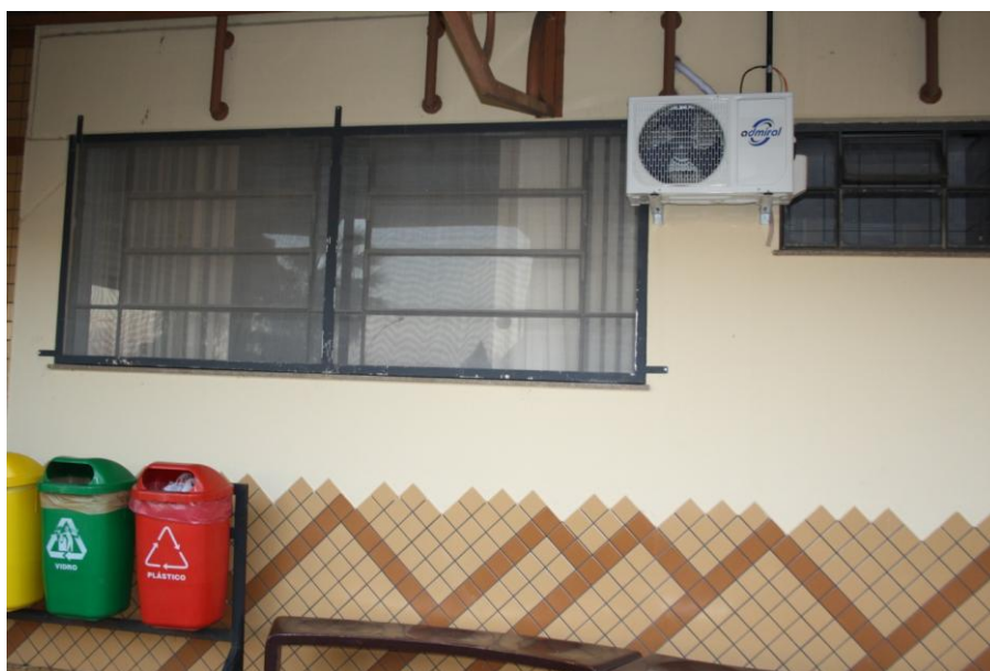
Figura 5: Janelas da sala com telas, colocação do ar condicionado e cortinas (Data 11.03.12).
