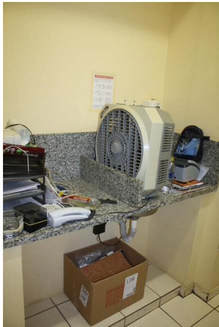
Figura 9: Pia externa antes da reforma. (Data 12.04.11).
