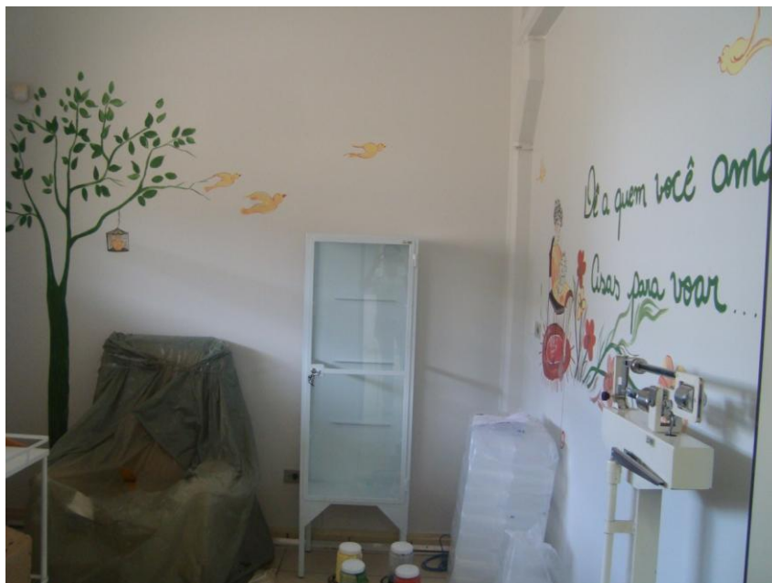
Figura 3: Sala em processo de finalização das modificações solicitadas pela Vigilância Sanitária (Data 07.11.11).
