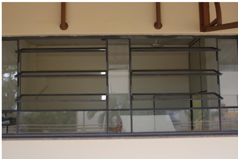
Figura 4: Janelas da sala antes das modificações, ainda sem telas (Data 16.08.11).
