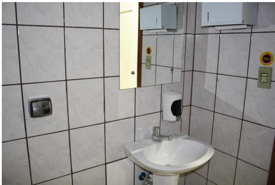
Figura 12: Banheiro externo após reforma (Data 16.08.11).
