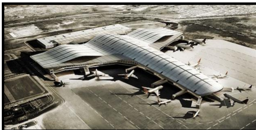
FIGURA 3 - Terminal três, Aeroporto Internacional de Guarulhos Fonte: < www.metalica.com.br >. Acesso em: 29 abr. 2012.
