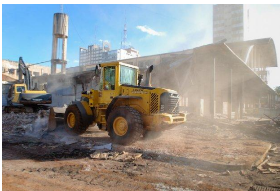
Figura 3 – O início da demolição. Fonte: Jornal Gazeta de Maringá, 2010.
