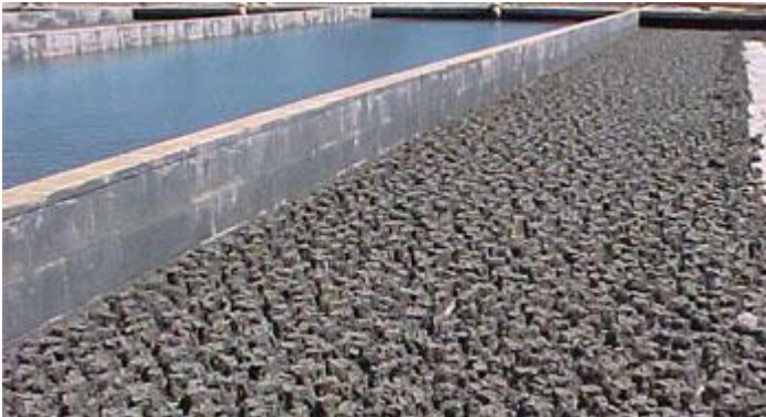
Figura 1: Lodo têxtil em poço de decantação
