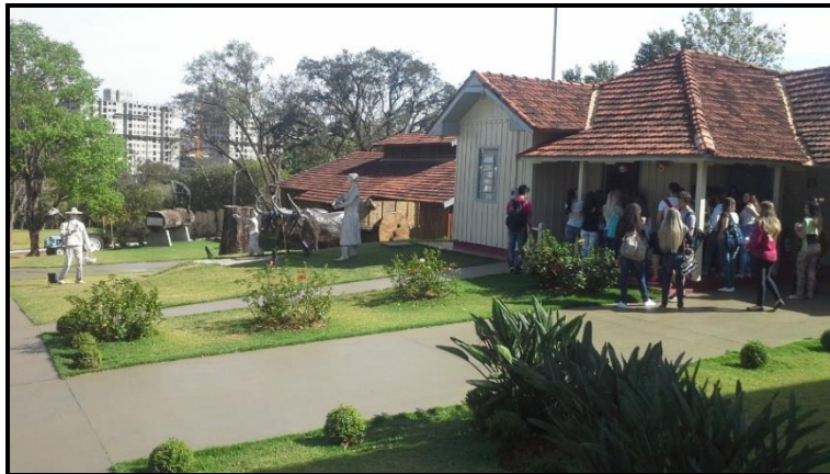
Figura 5 - Fachada da Casa do Pioneiro e da Tulha ao fundo
