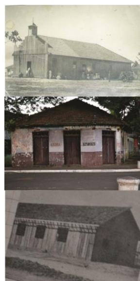
Figura 2 - Ilustração de edificações demolidas Fonte: Acervo Sr. Joaquim Moraes; Autoras, 2018; Acervo Srª Eduvirgem B. Silva
