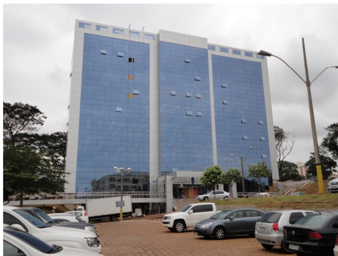
Figura 2. Foto do Edifício Administrativo (Bloco 11) do Centro de Ensino Superior de Maringá/ Unicesumar.
