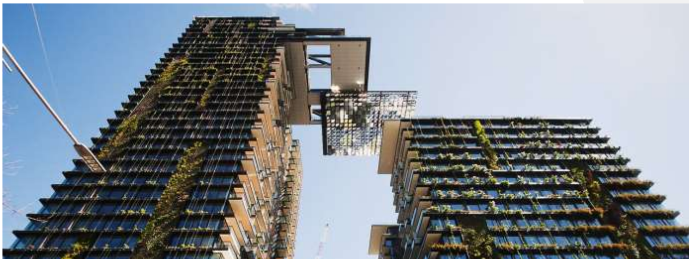
Figura 2: Topo do edifício projetado por Jean Nouvel com helioestato de filmes finos – Sydney, Austrália.
