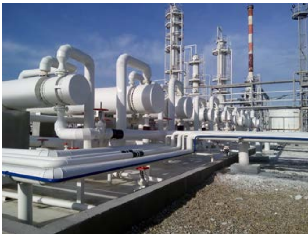
Figura 1 - Trocadores de calor em uma refinaria
